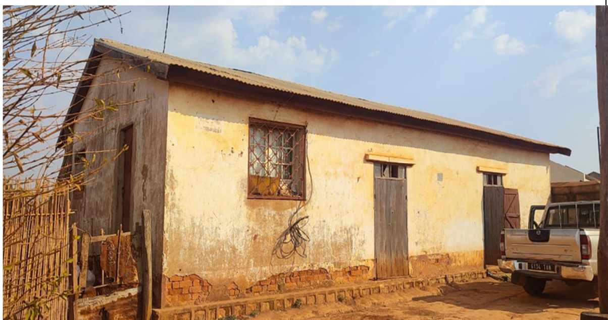
Magasin de stockage à Ambatomanjaka
